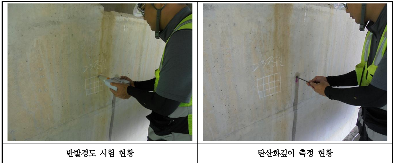
【사진 27.4.1】 콘크리트 내구성조사 현황
