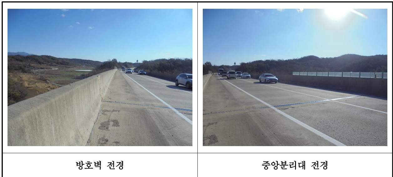
【사진 27.3.23】 방호벽 및 중앙분리대 전경
