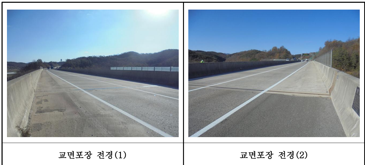
【사진 27.3.19】 교면포장 전경
