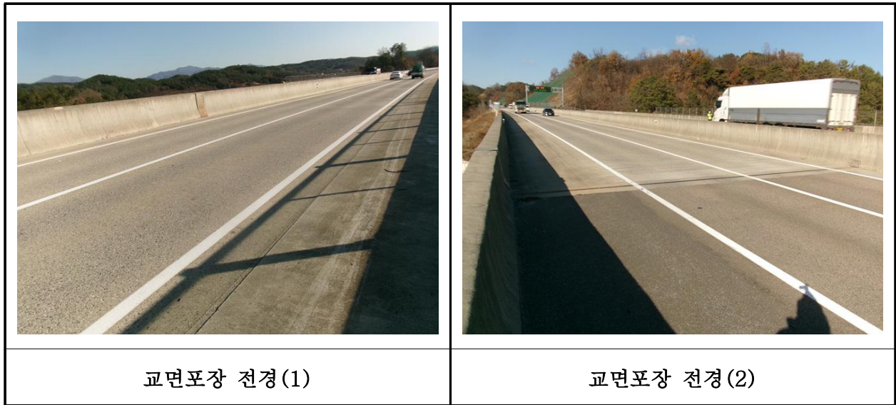
【사진 27.3.44】 교면포장 전경
