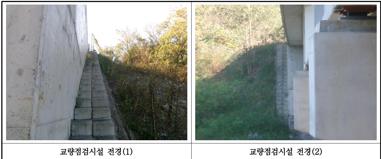
【사진 27.3.25】 교량 점검시설 전경
