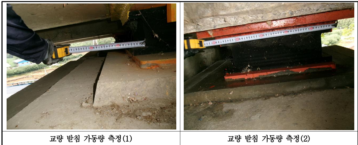
【사진 27.3.40】 교량받침 이동량 측정
