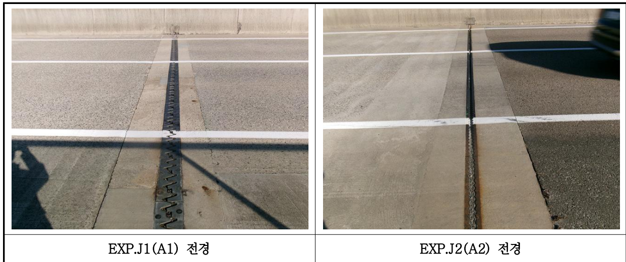
【사진 27.3.41】 신축이음장치 전경
