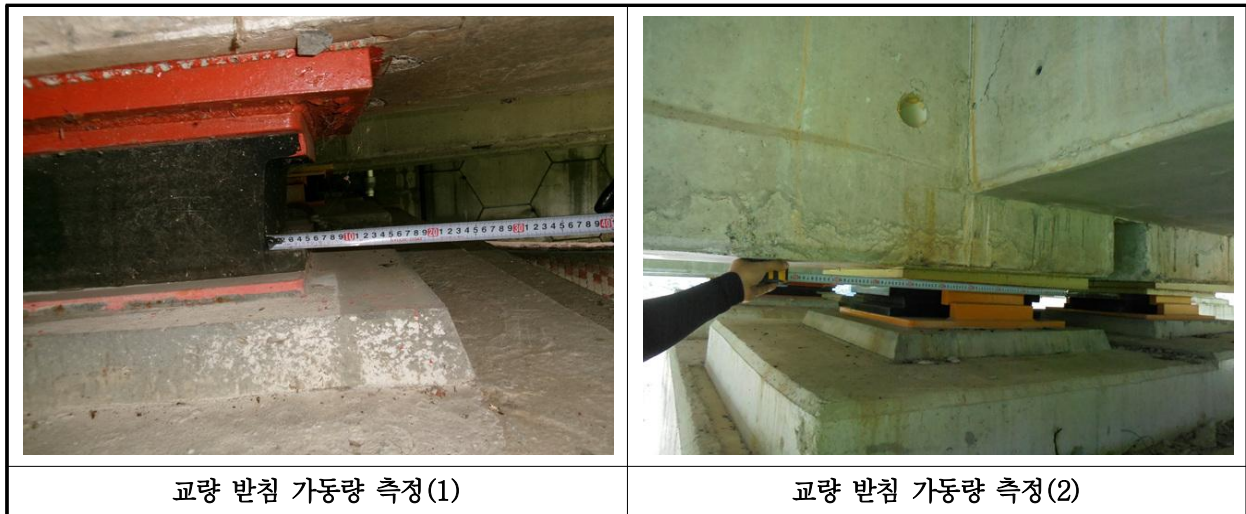
【사진 27.3.15】 교량받침 이동량 측정
