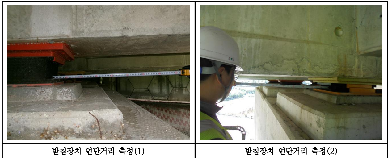
【사진 27.3.14】 교량받침장치 연단거리측정
