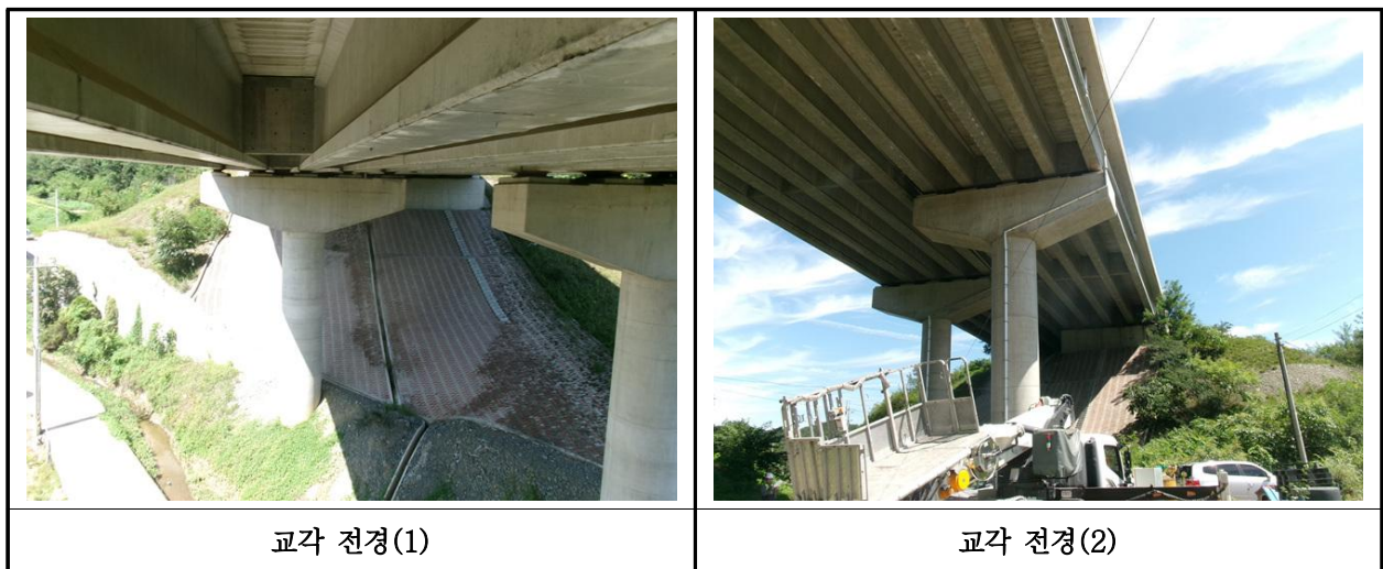
【사진 27.3.35】 교각 전경
