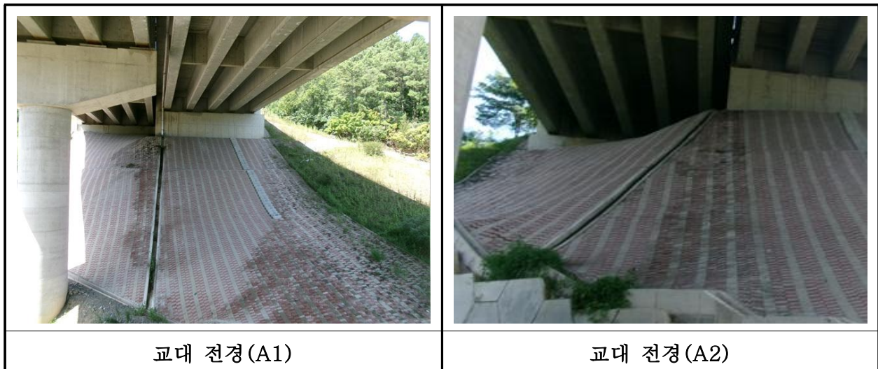
【사진 27.3.8】 교대 전경
