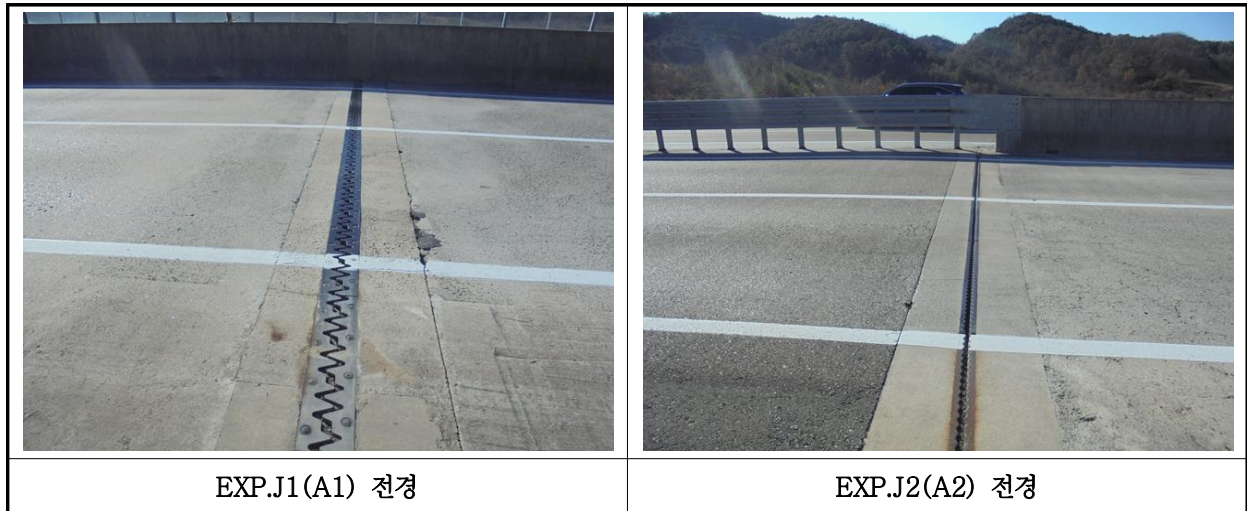
【사진 27.3.16】 신축이음장치 전경
