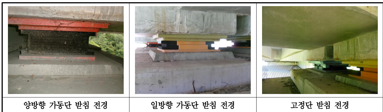
【사진 27.3.12】 교량받침 전경
