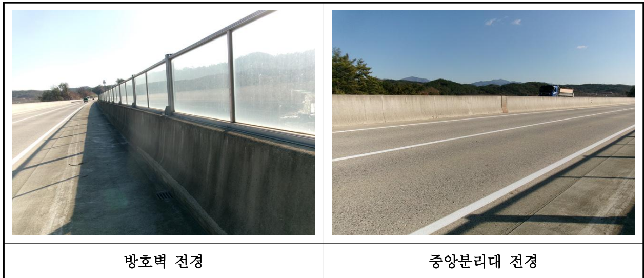
【사진 27.3.48】 방호벽 및 중앙분리대 전경
